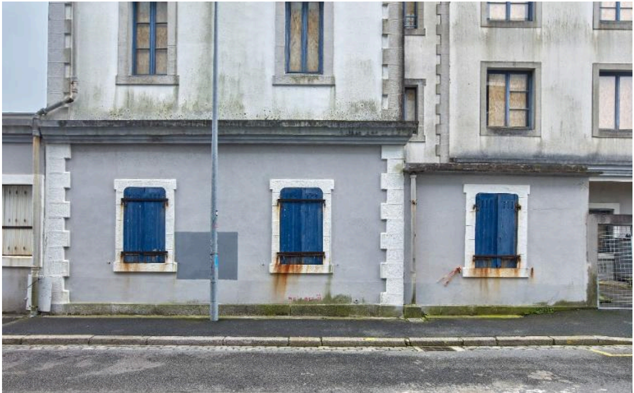
Ancien bureau du port : le premier bâtiment intégré dans des adjonctions de volumes
