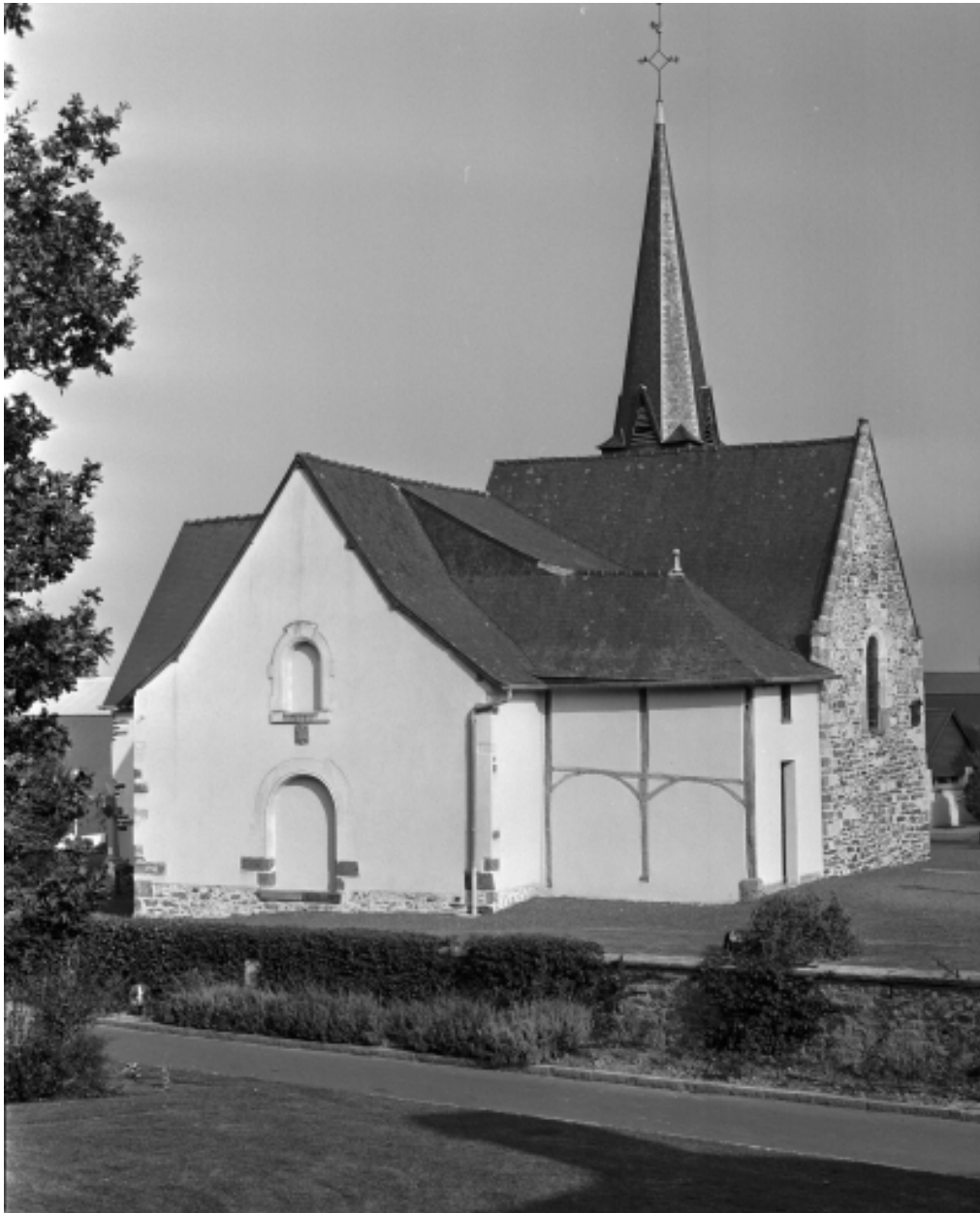
Elévation ouest, état après restauration
