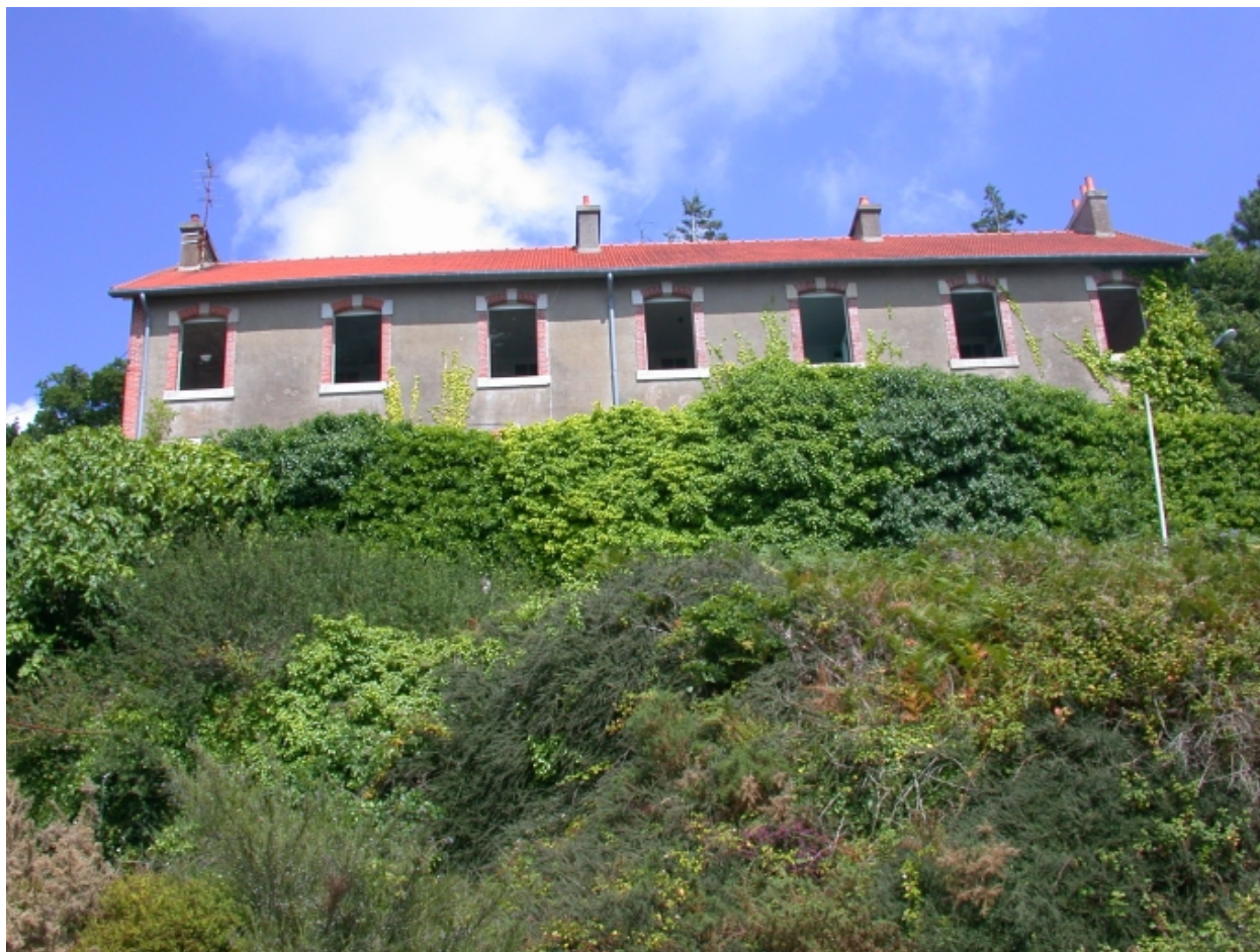
Vue des bâtiments administratifs désaffecté, situés en surplomb
