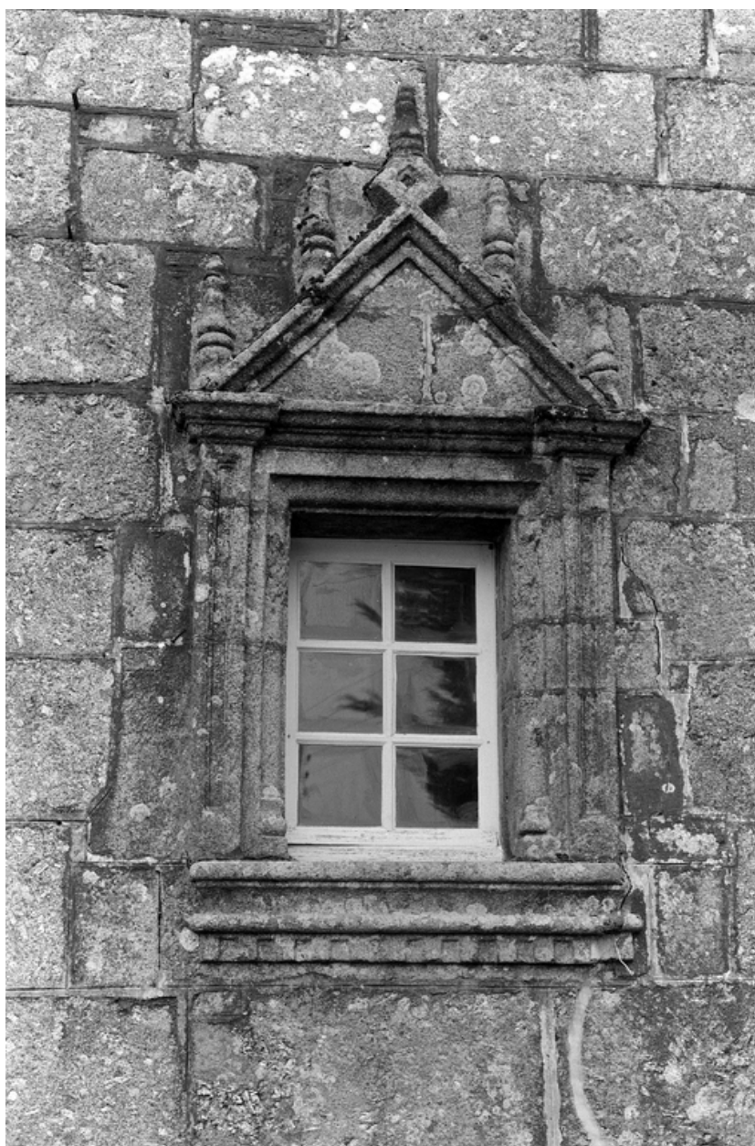
Corps de bâtiment ancien, façade ouest, 1er niveau : détail de la fenêtre sud
