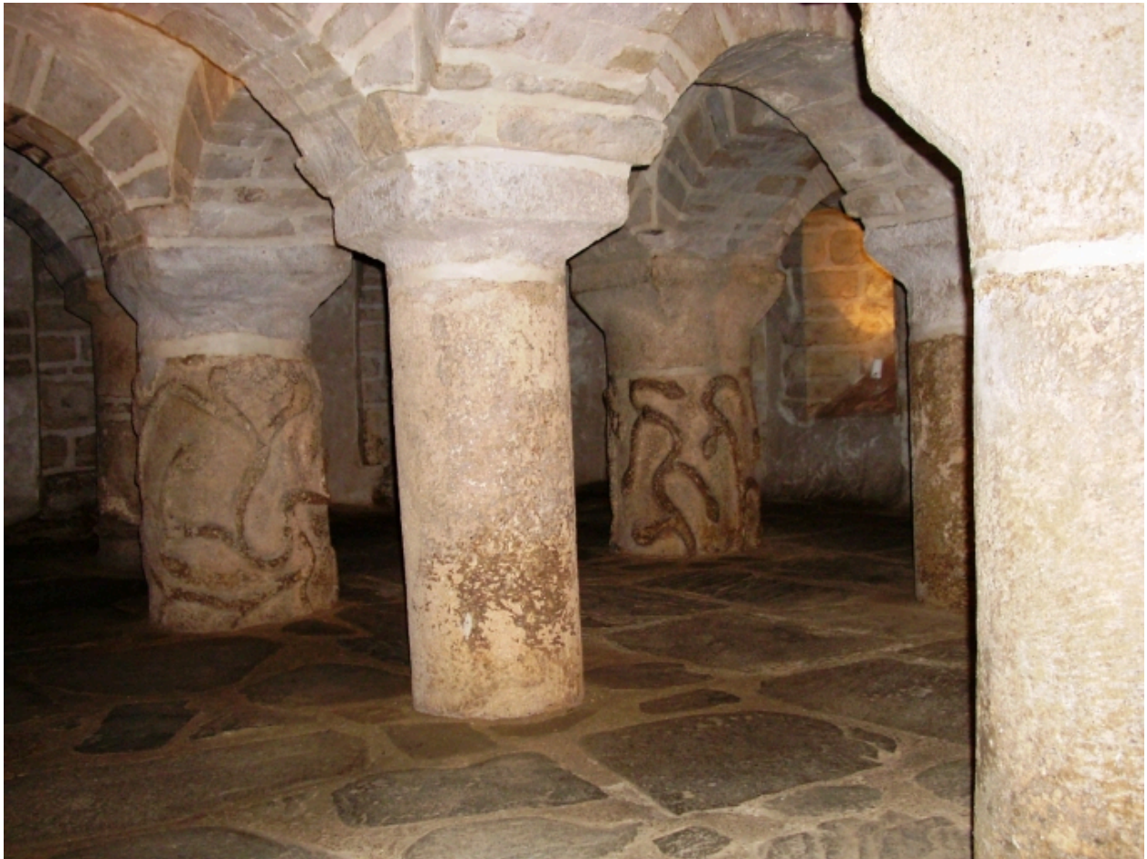
Lanmeur, église paroissiale Saint-Mélar : crypte, vue transversale nord-est, détail
