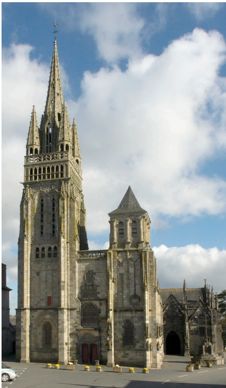
Vue générale de la façade ouest
