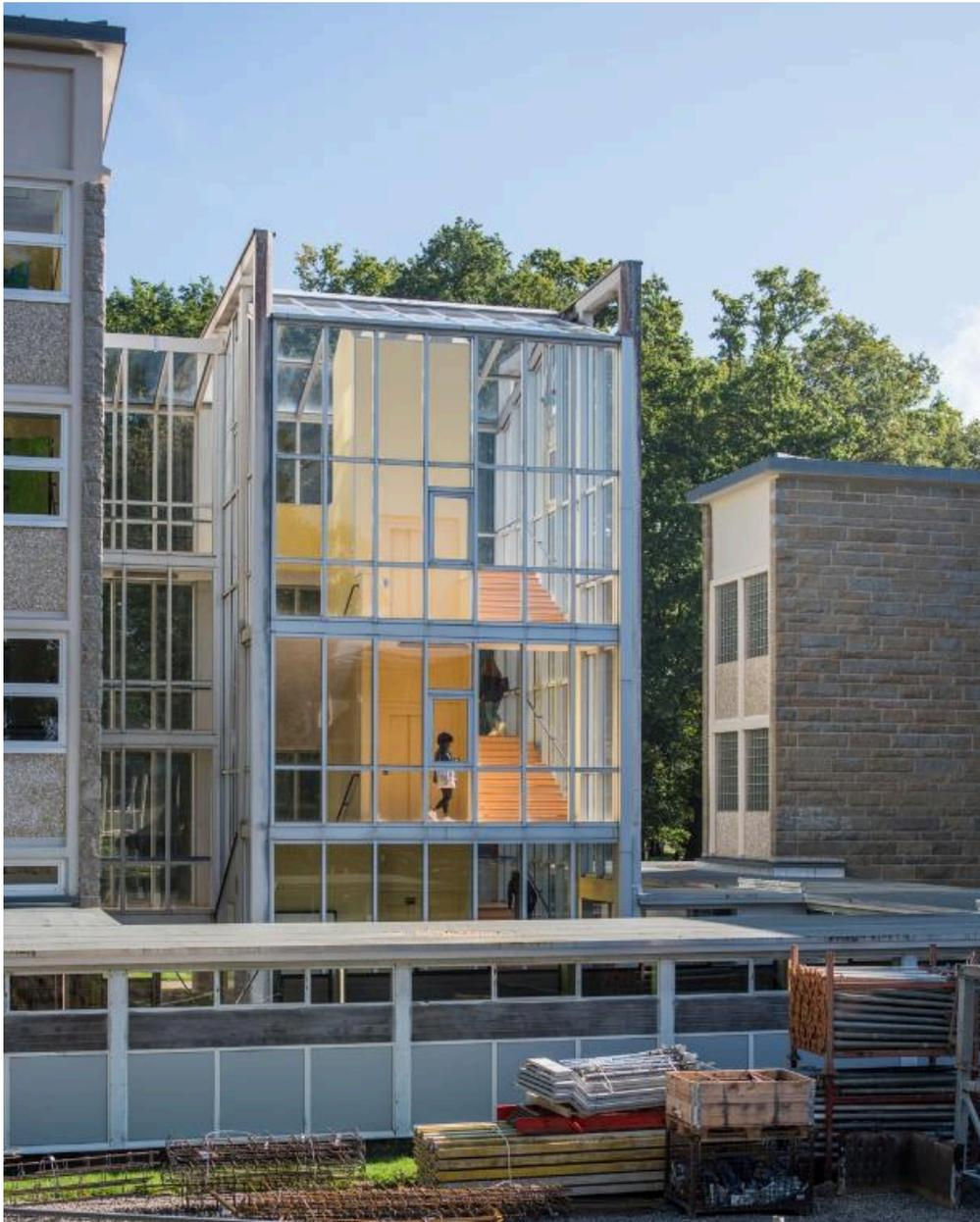
Cage d'escalier hors œuvre entre l'internat E et l'externat C. Ajout postérieur à la construction. A droite, l'escalier est du bâtiment C (externat), et ses quatre verrières en pavés de verre.
