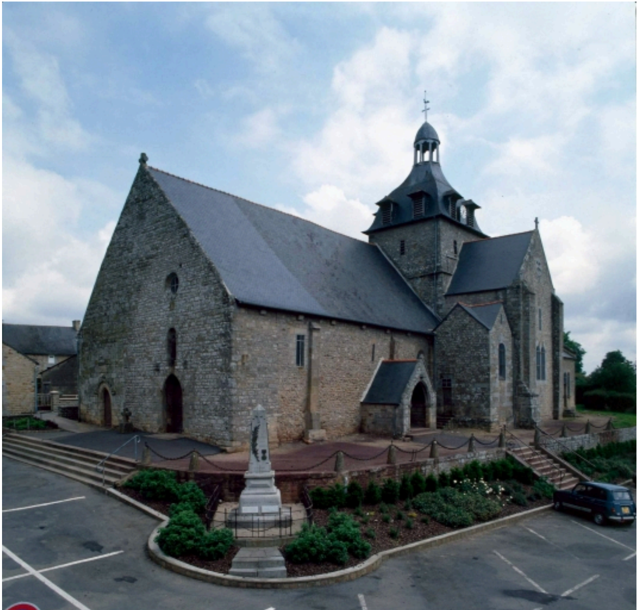
Élévation sud-ouest : vue générale
