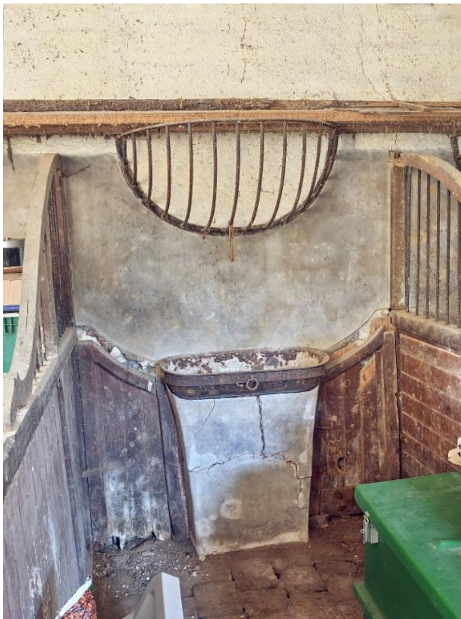
Vue de détail d'une stalle.
