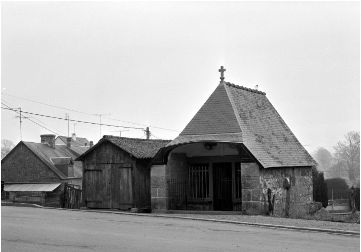
Elévation Nord-Ouest : vue générale
