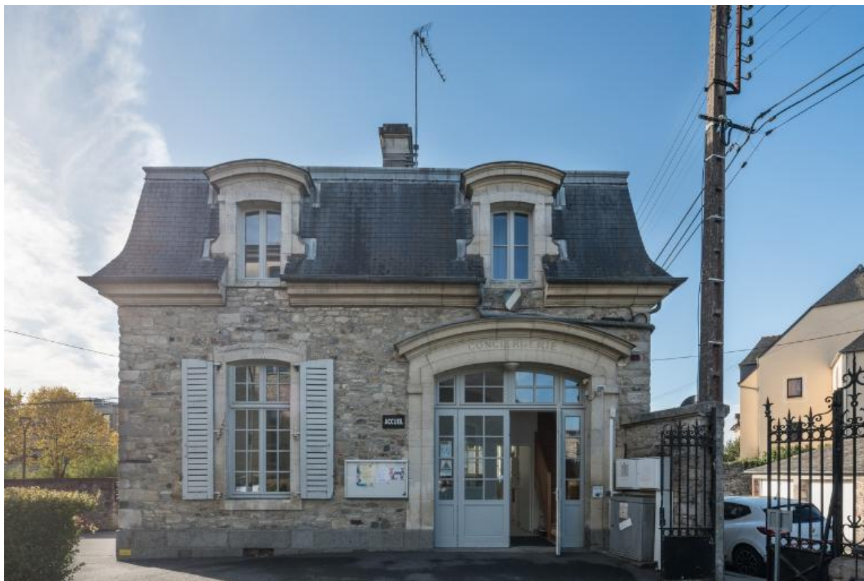
Loge du gardien à l'entrée du lycée.
