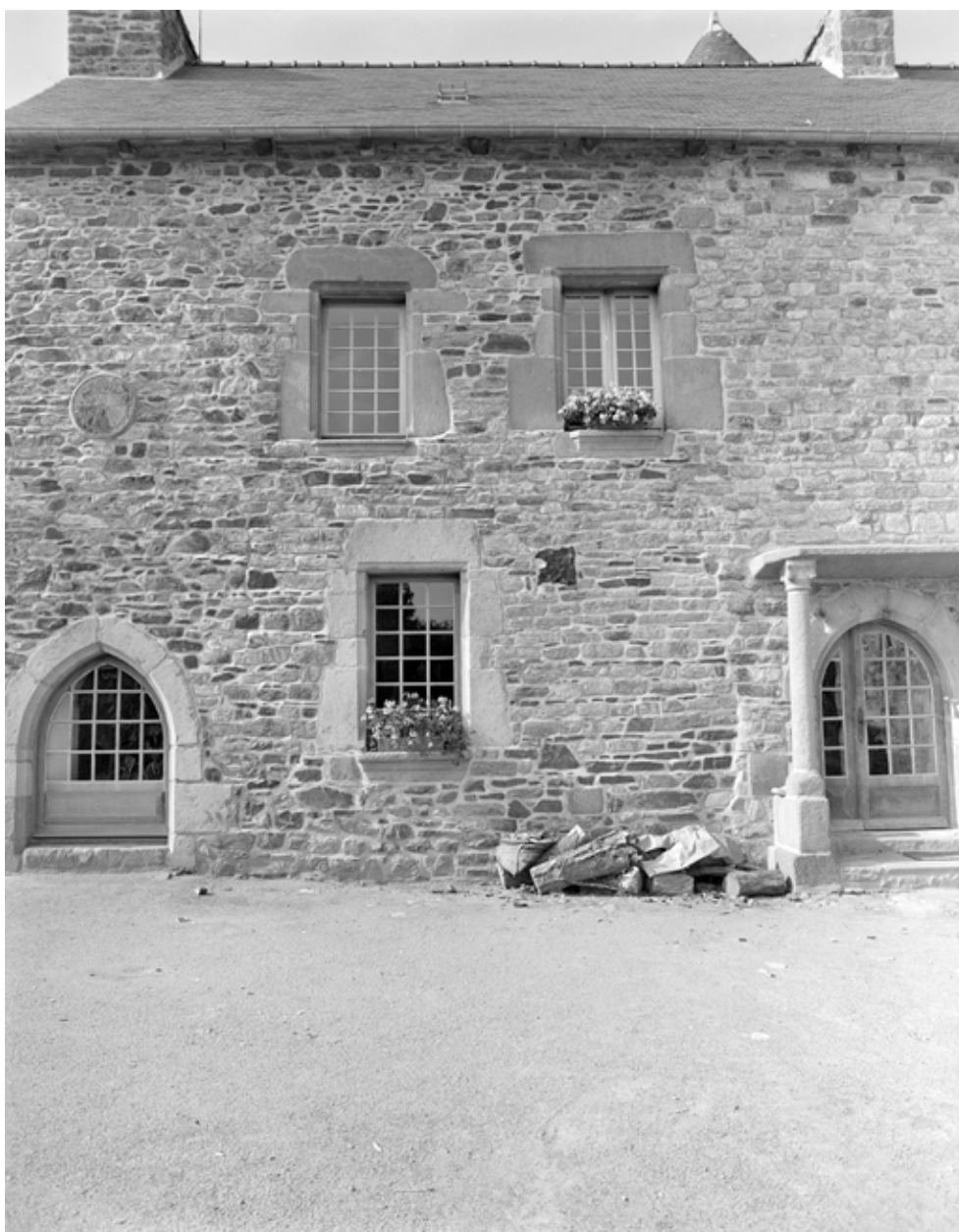
Fenêtre sud (ouest de la porte)
