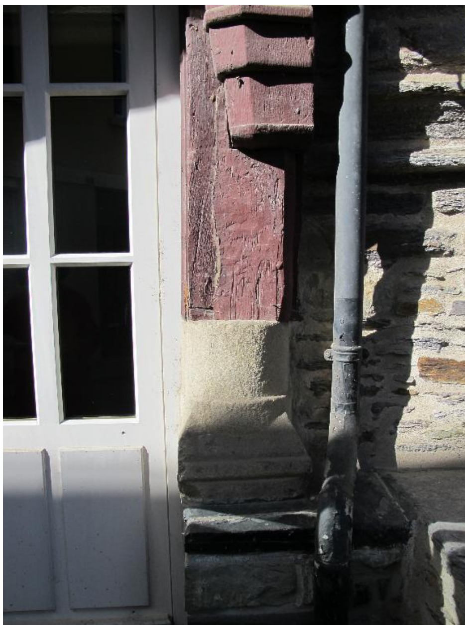
Maison : le poteau repose sur une base en grès (état en 2012)
