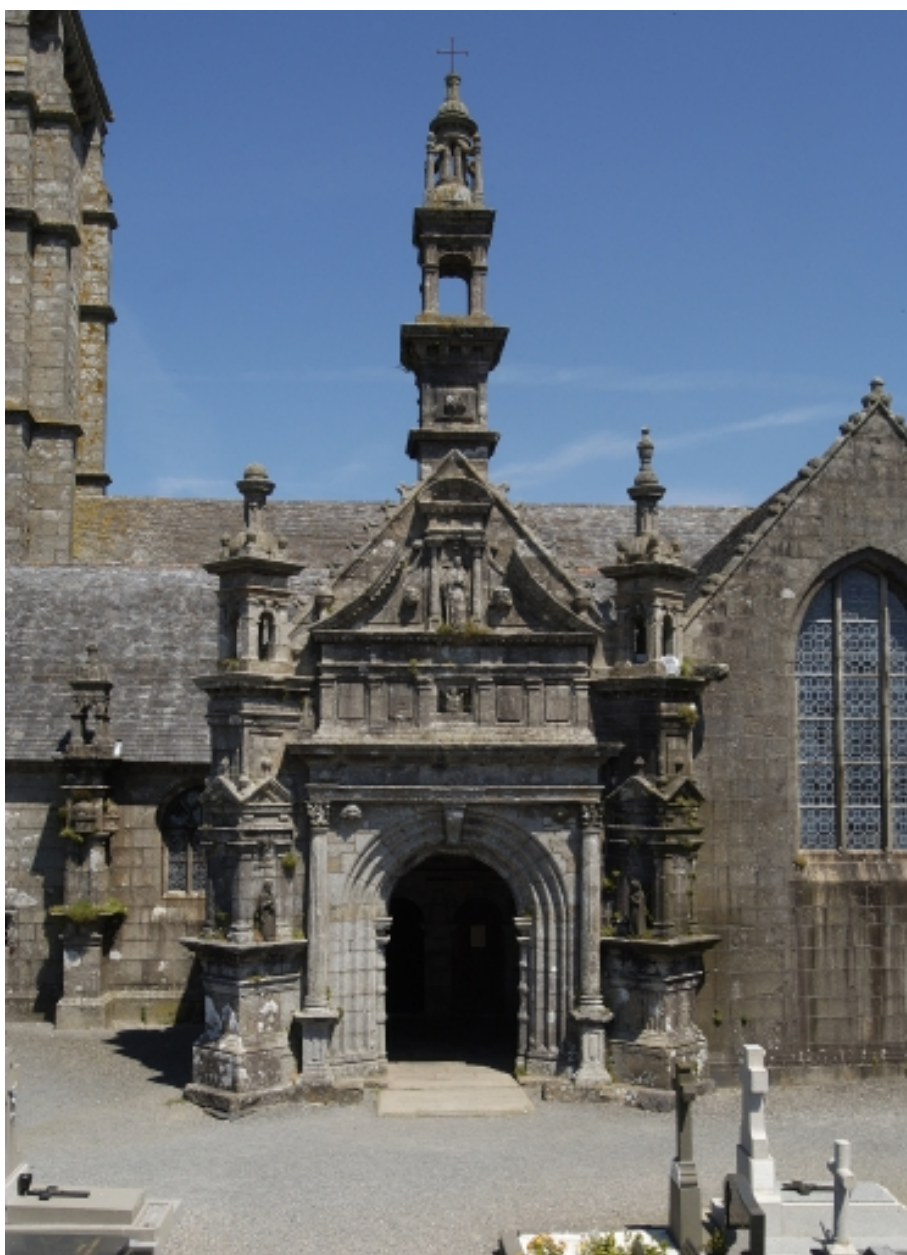
Porche sud, vue générale
