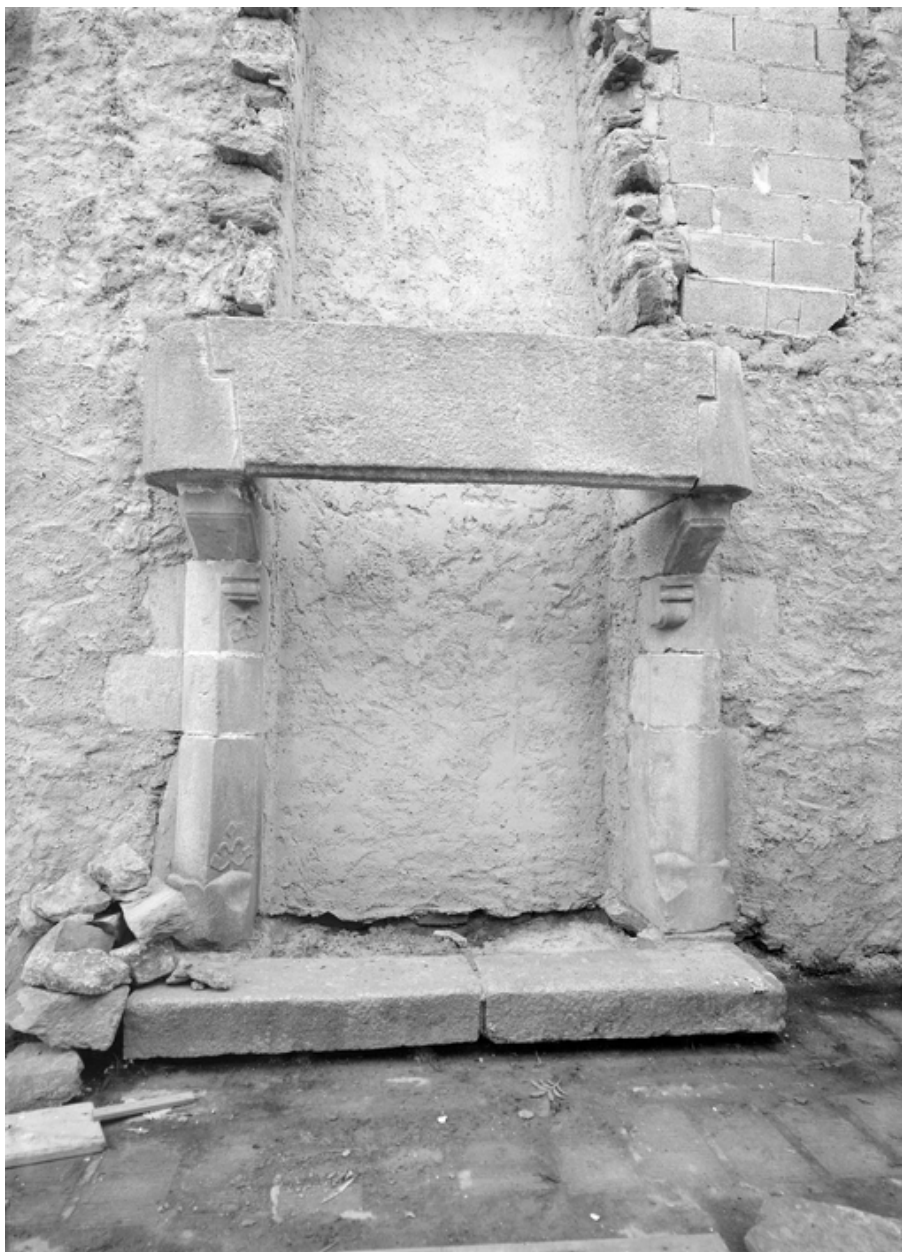
Cheminée au premier étage
