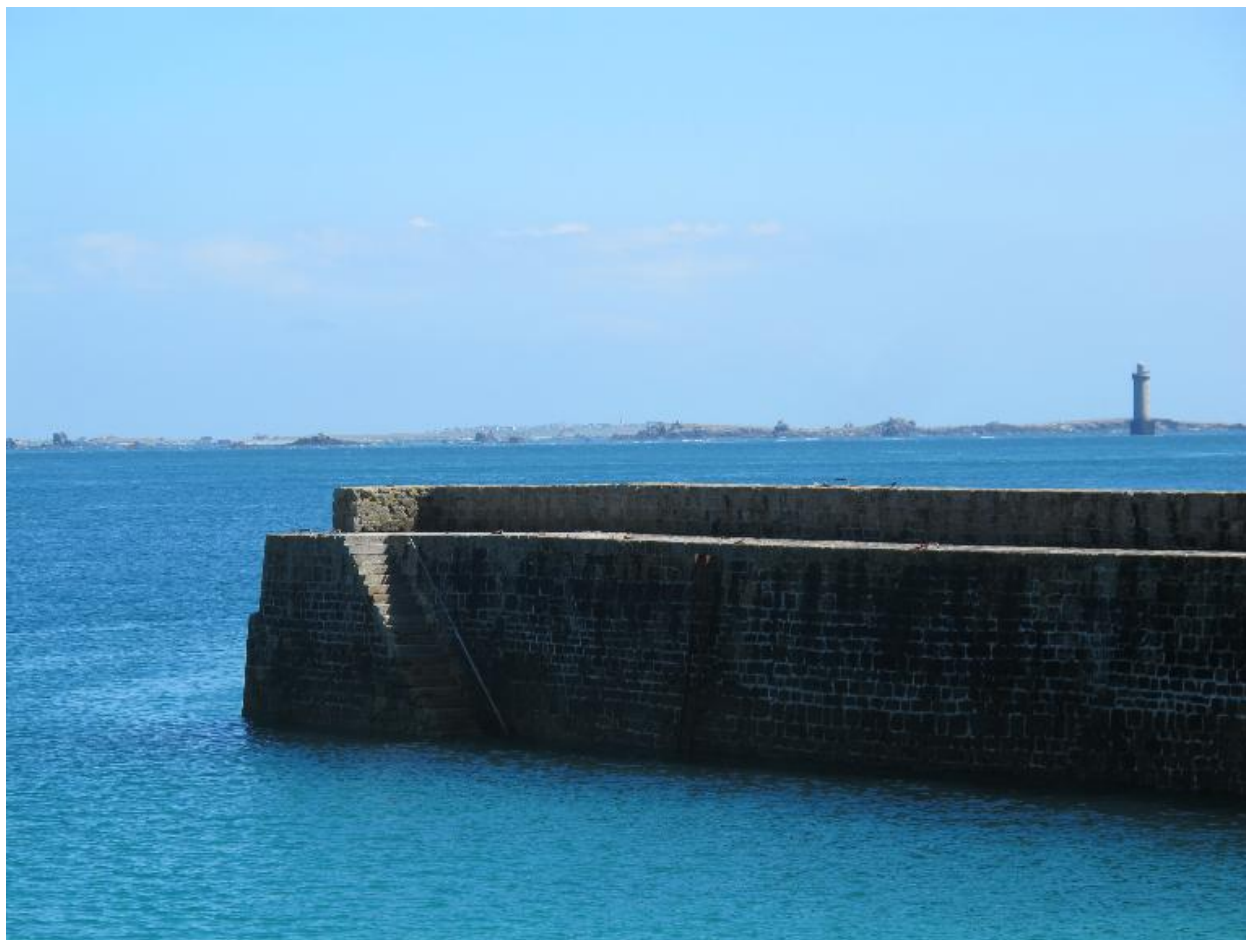
Porz ar Lan, digue
