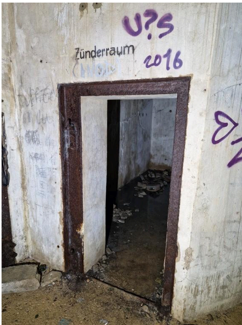
Vue intérieure du bunker - cuve nord pour canon de 34 cm avec magasins de munitions. Ce bunker conserve sa peinture blanche et des marquages
