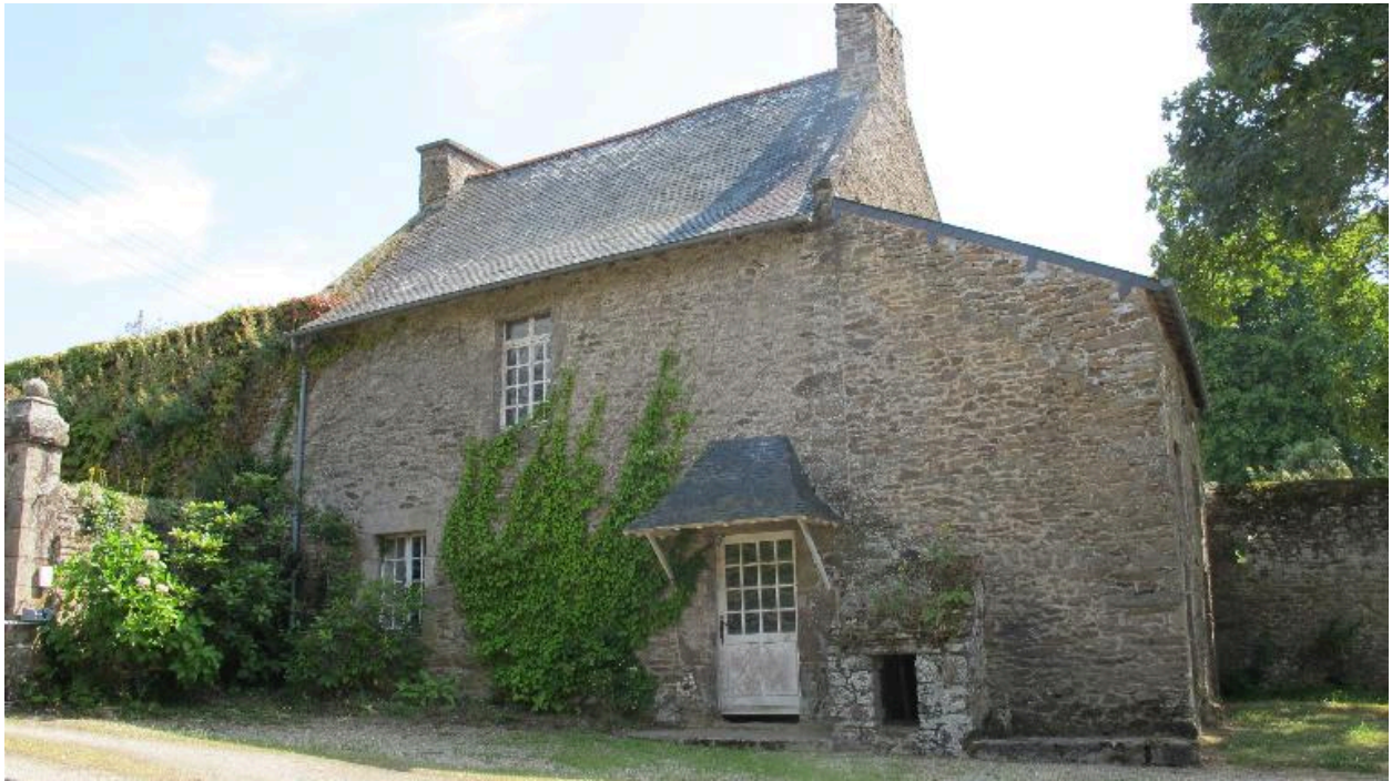
Logis du jardinier à l'entrée de la cour, avec niche pour le chien en pierre
