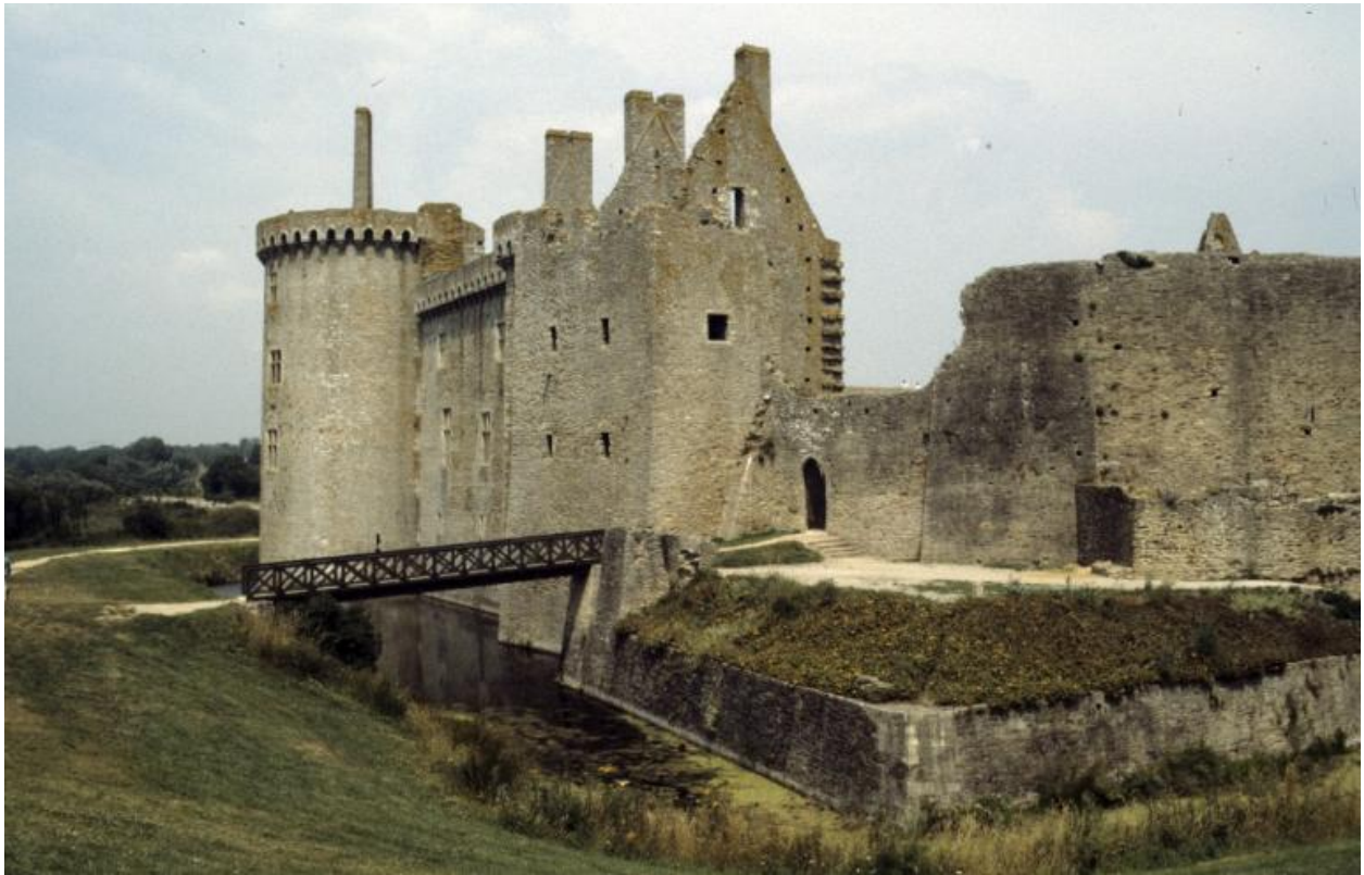
Château fort, logis ouest et bastion, vue sud.
