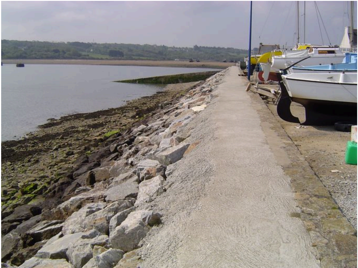
Digue du terre-plein de Roche-Noire
