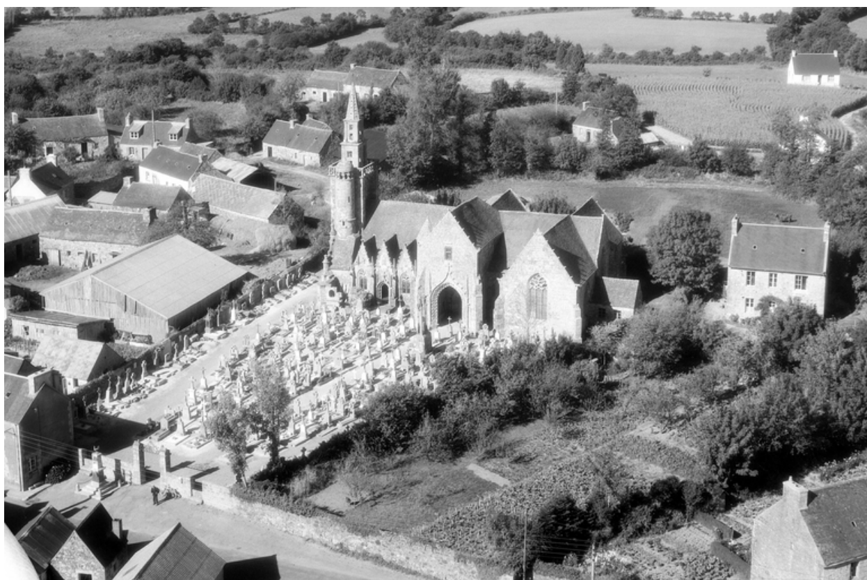
Vue de situation prise du sud est
