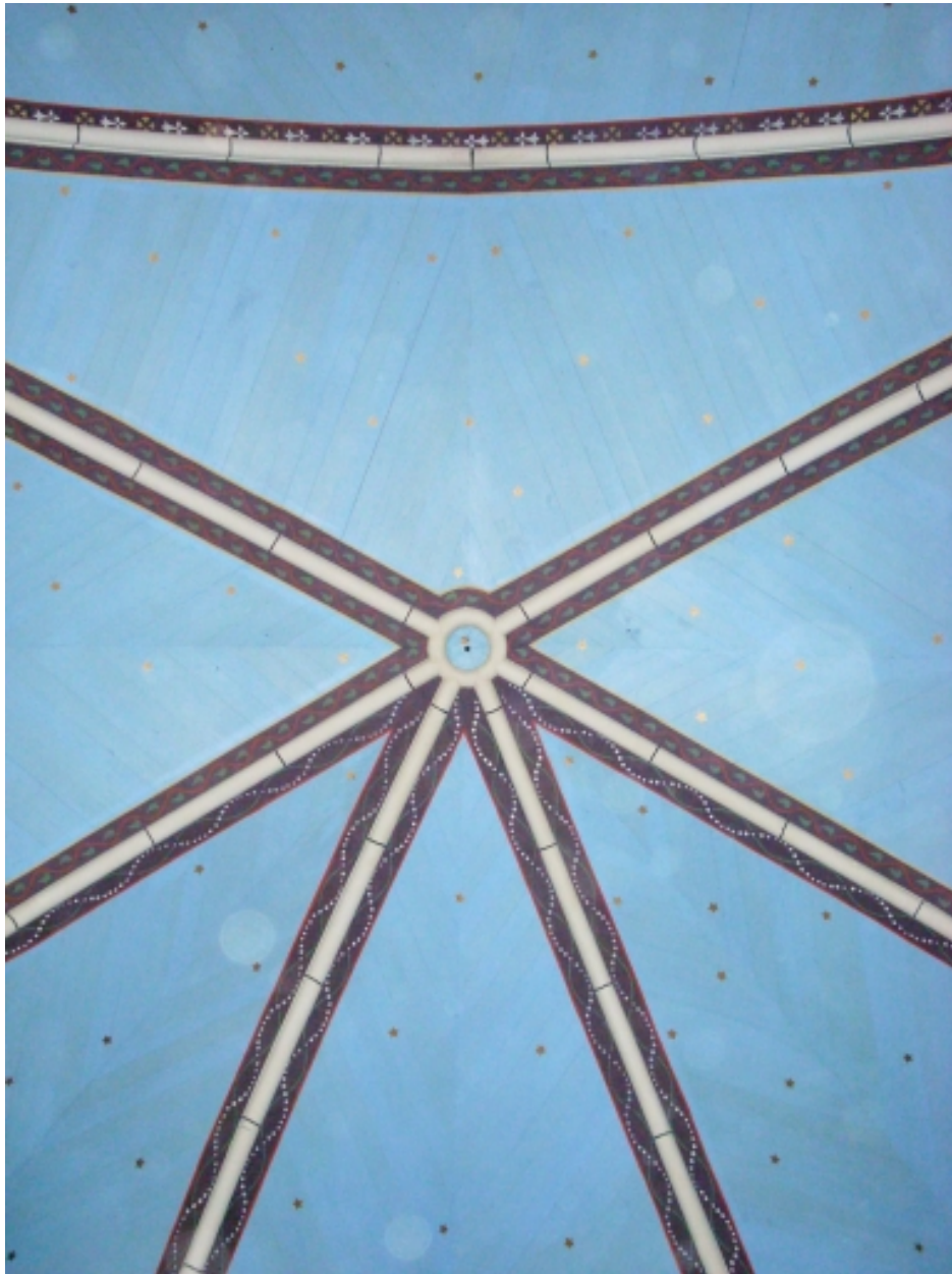
Landivisiau, chapelle Notre-Dame-de-Lourdes : lambris de couverture dans le choeur, détail
