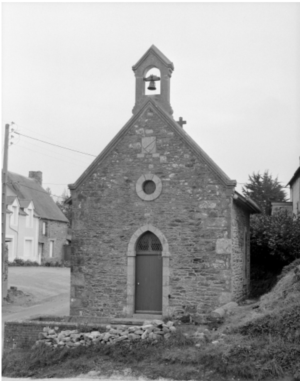
Elévation ouest : vue générale
