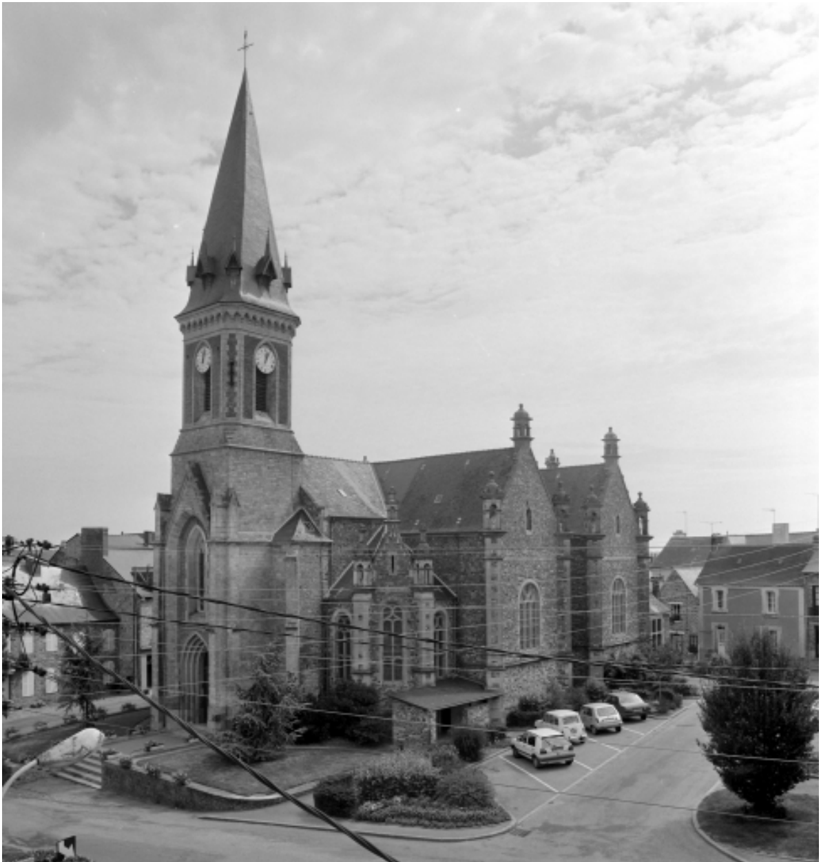
Elévation Sud-Ouest : vue générale.
