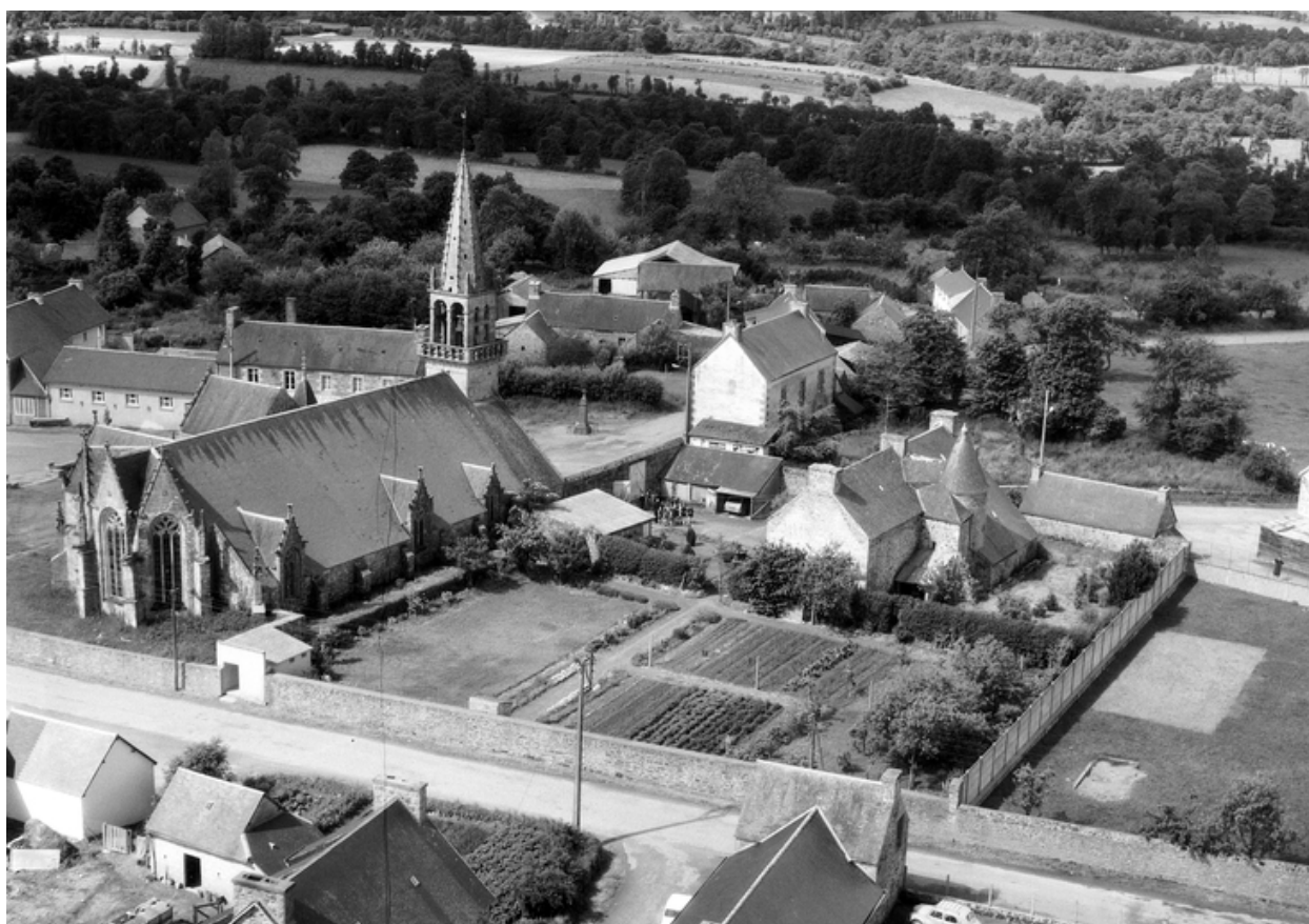
Vue prise du nord est
