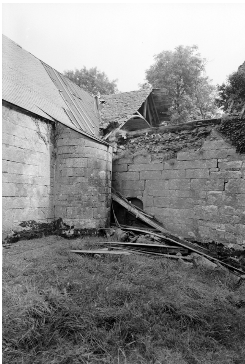
Vue de la tourelle accolée au mur sud de la nef et du mur ouest du bras sud
