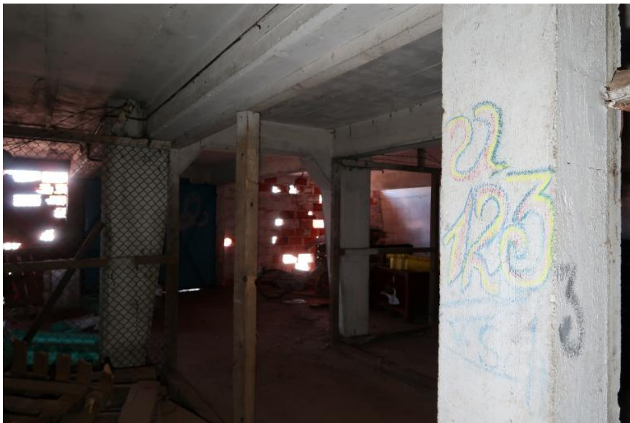
Premier étage : extrémité nord, marquage "U 123" (box 28)
