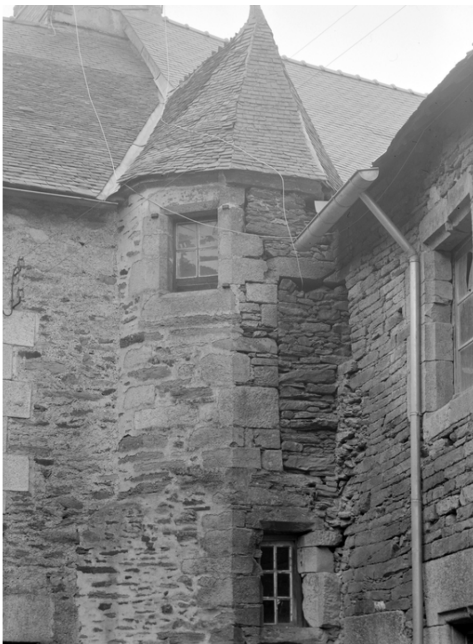
Maisons B et C, tourelle d'escalier niveau supérieur.
