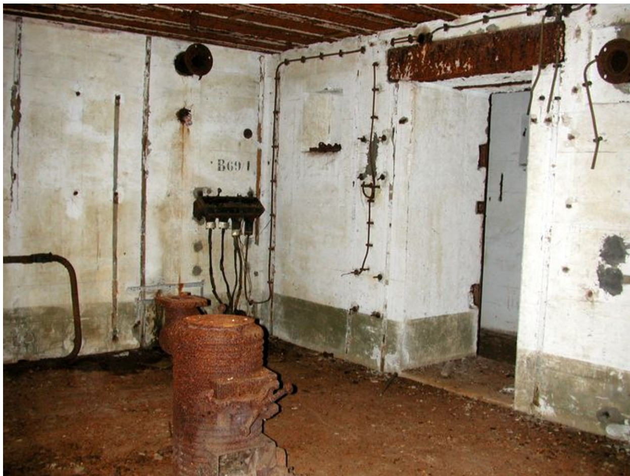
Vue de la chambre de troupe de droite : poêle de type Wt 80K, châssis tubulaire de couchette posé contre le mur, boîtier de connexion téléphonique surmonté du numéro "B 69/1" et câblage... (état en 2003)
