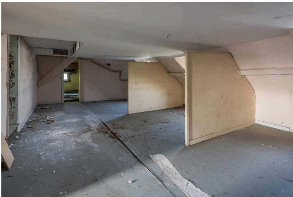
Dortoir aménagé sous les combles.
