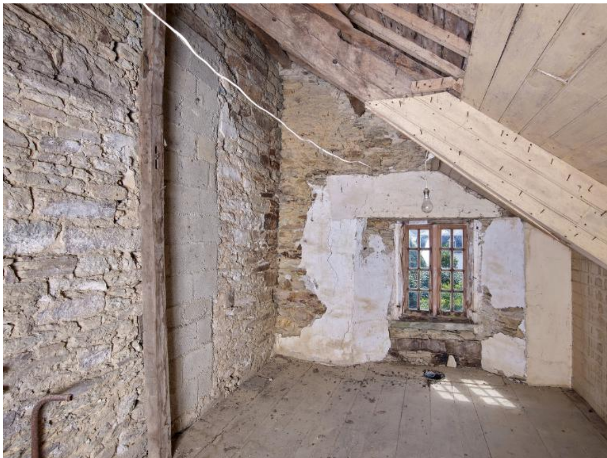
Logis. Etage de l'appentis postérieur. Vue de la partie ouest
