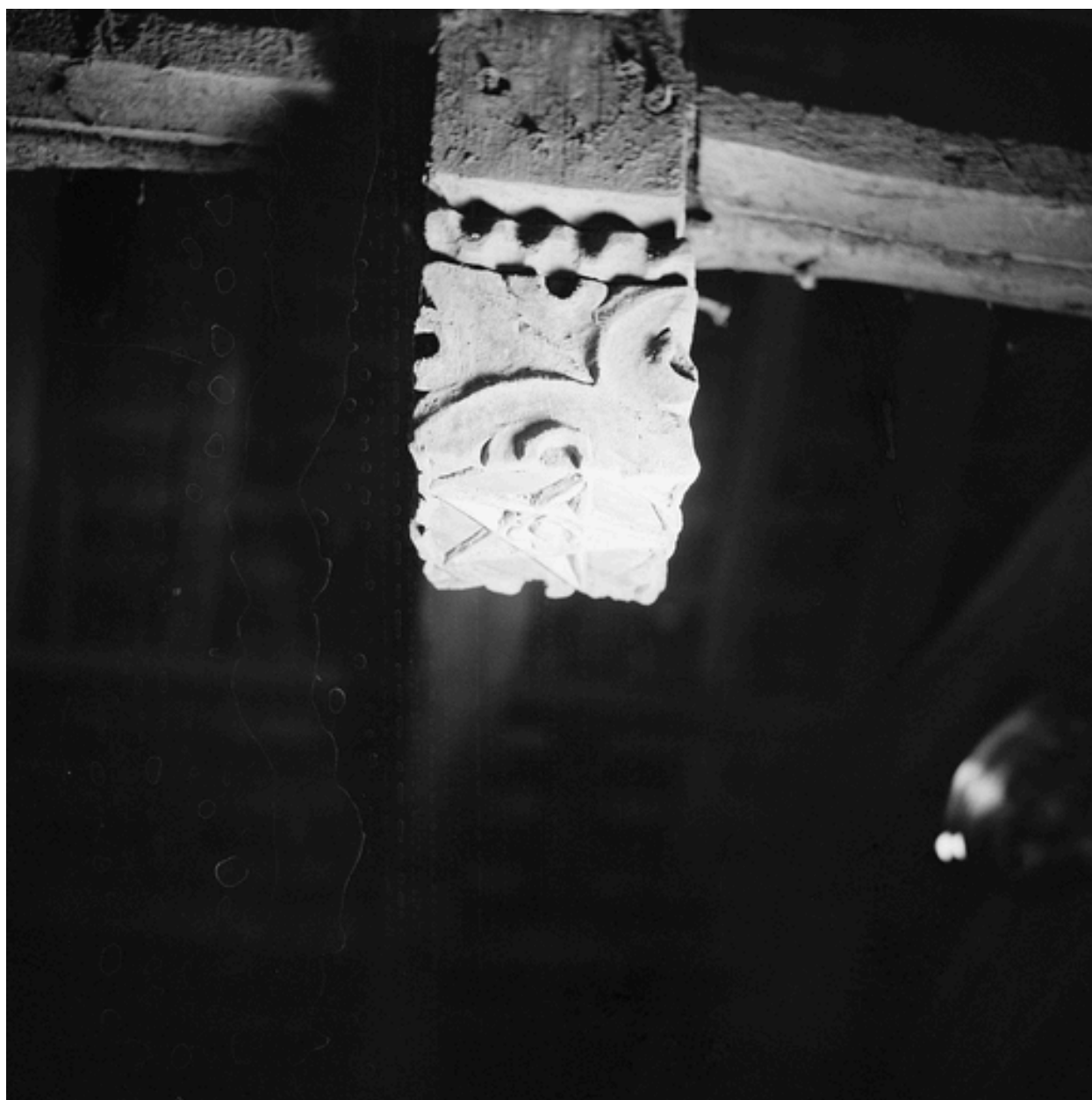
Charpente, détail de la clé 5.
