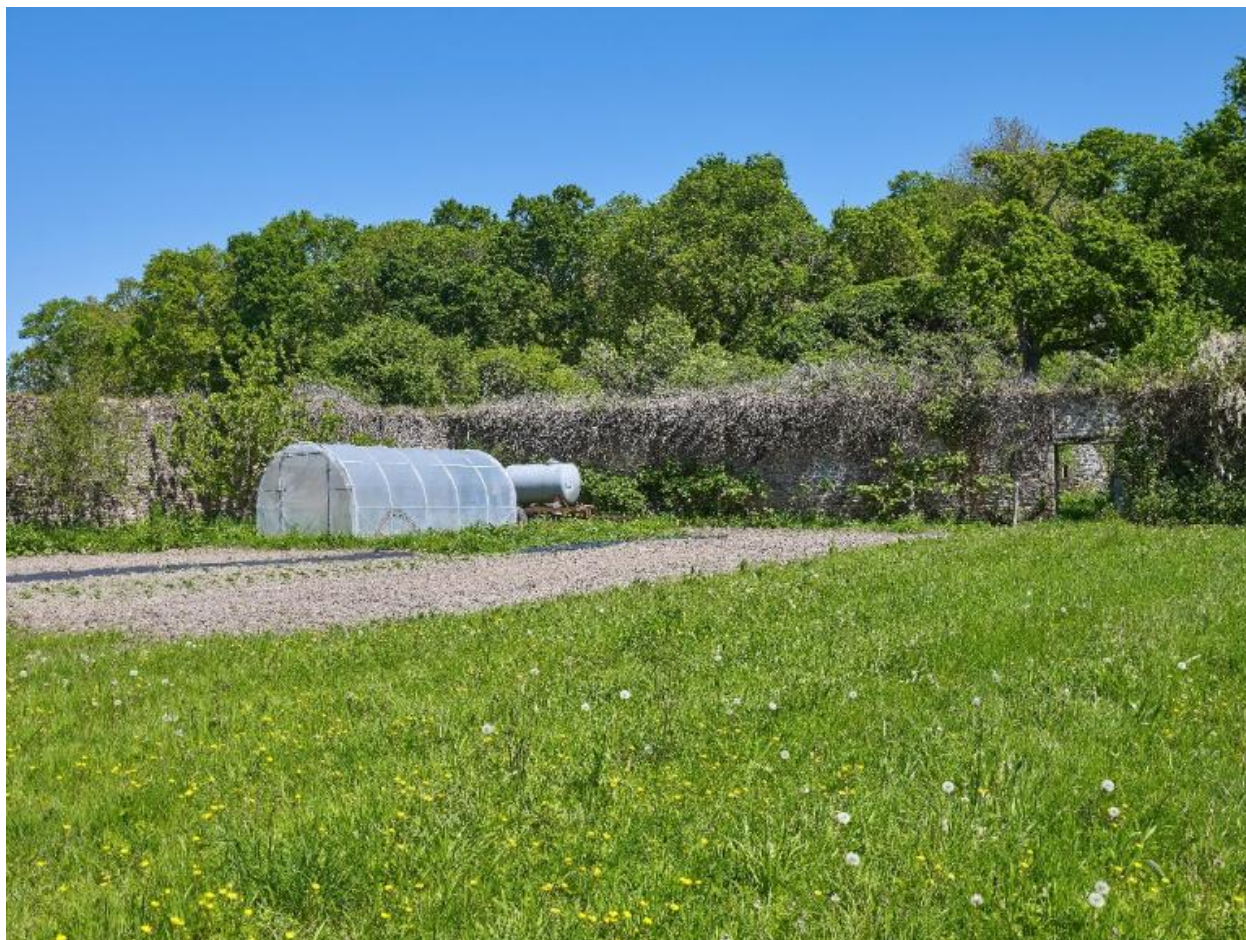
Mur de clôture
