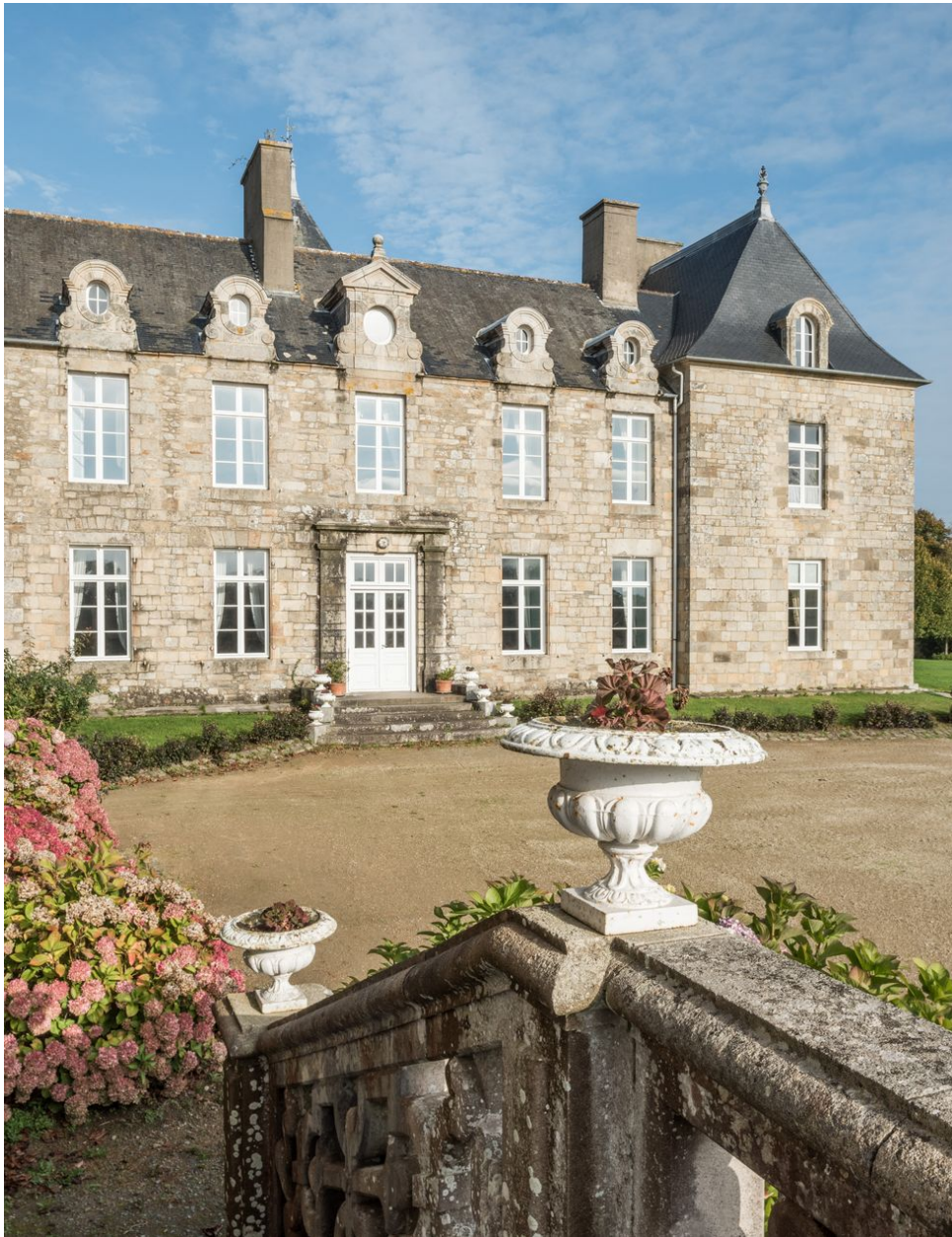
Vue générale de l'aile nord, façade méridionale
