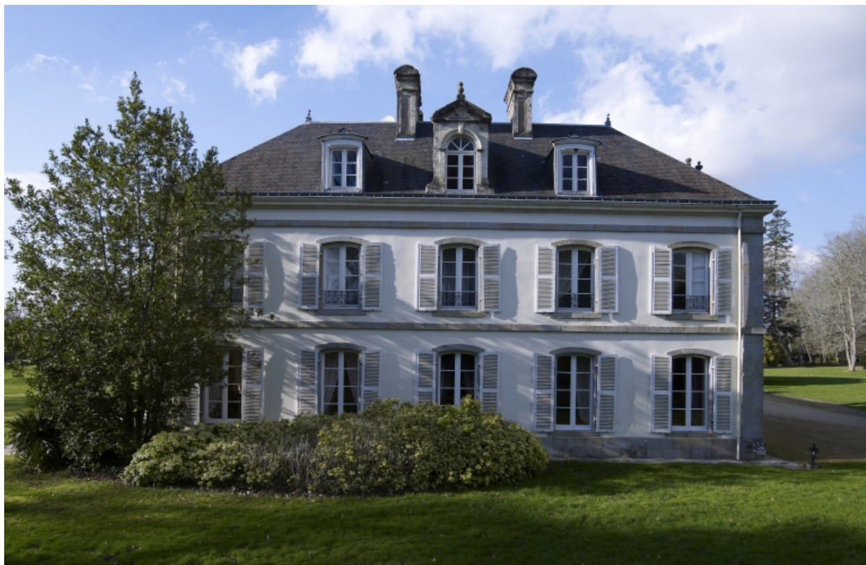
Pavillon est, élévation latérale est
