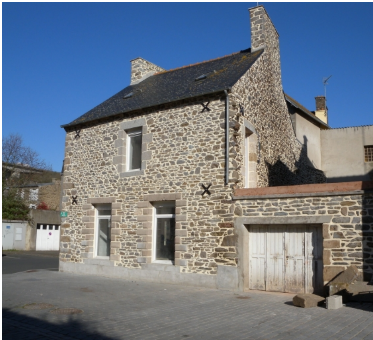
Bâti traditionnel du Légué, rénové
