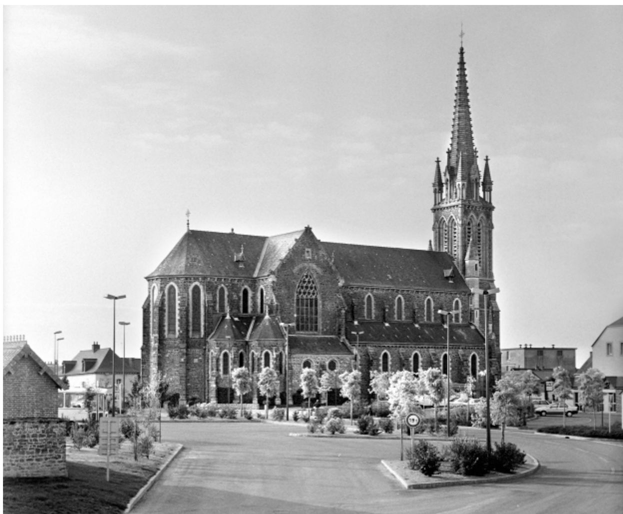
Vue générale nord est
