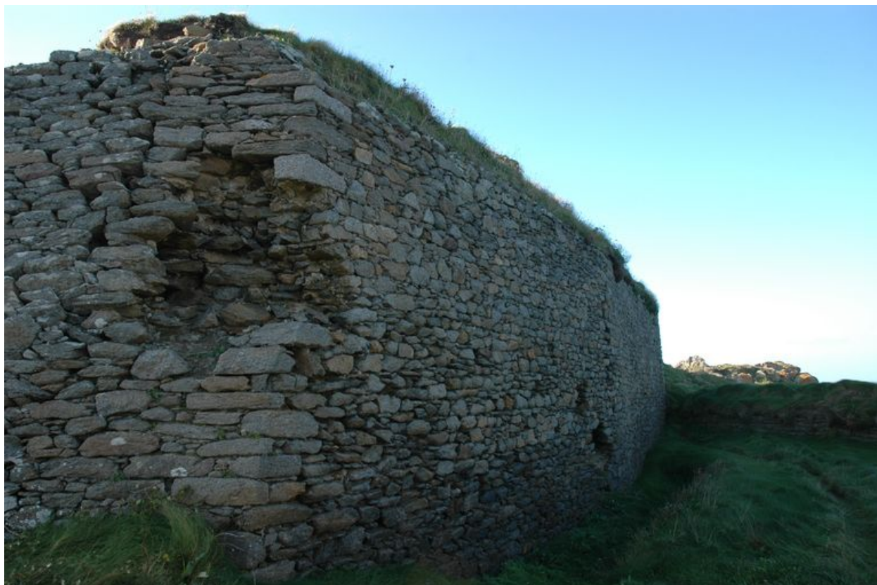
Massif de maçonnerie soutenant le parapet de la batterie haute
