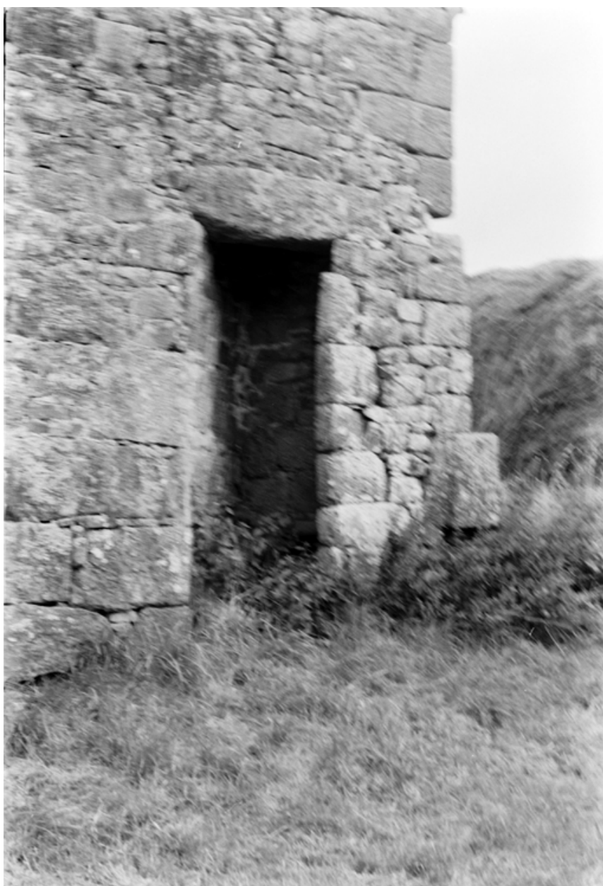
Maisons (Kerohou) : maison à l'est du village, détail de la face : sud du bâtiment sud ouest
