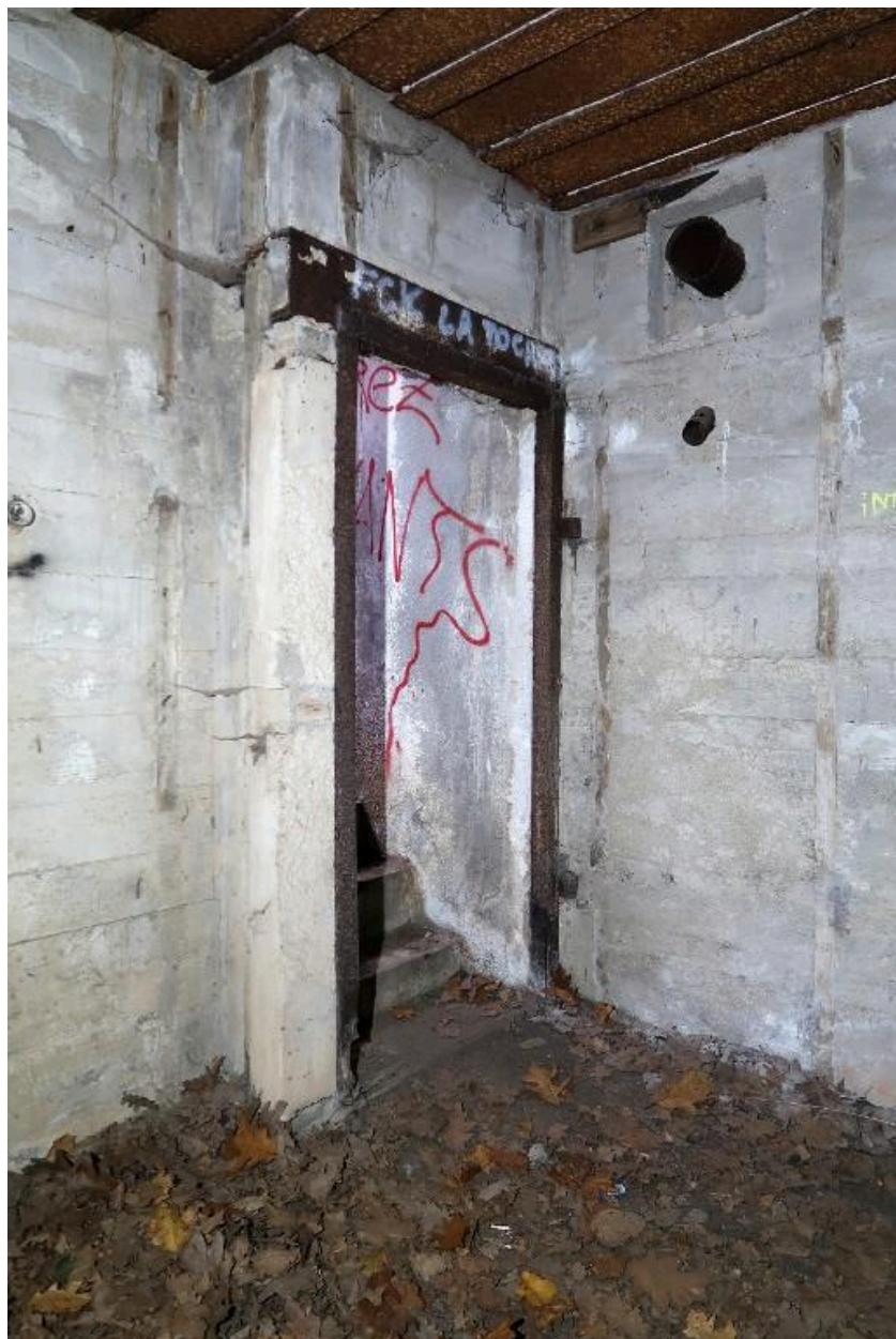
Vue du bunker-poste de direction de tir de type Fl229 pour télémètre : débouché de l'escalier desservant les salles de calculs et des opérations. Près du plafond, vestiges des voliges clouées au mur. Les murs sont peints en blanc
