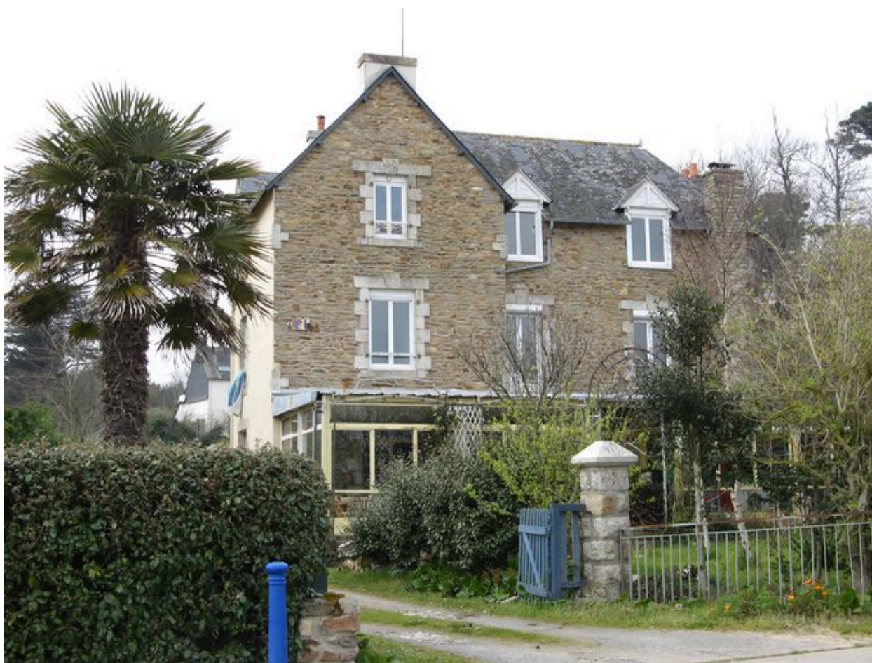
Façade principale de la villa 19 boulevard de la Laïta
