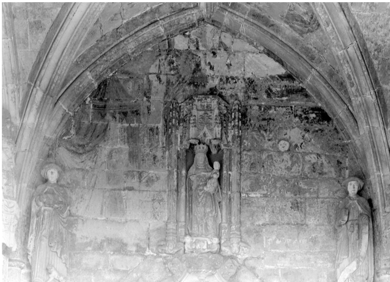
Porche intérieur : partie supérieure du mur nord
