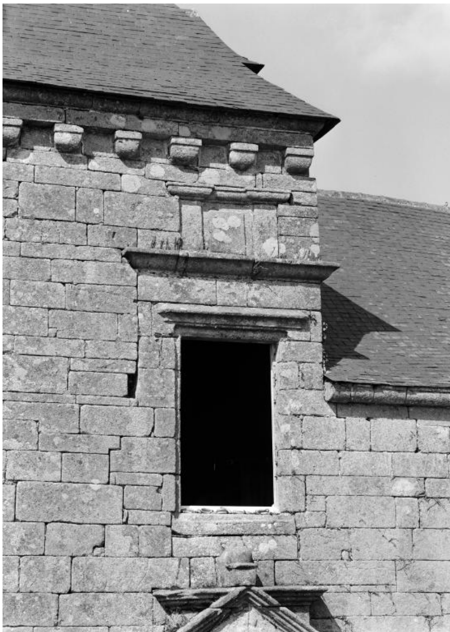
Détail fenêtre et corniche de la travée centrale sur la façade sud
