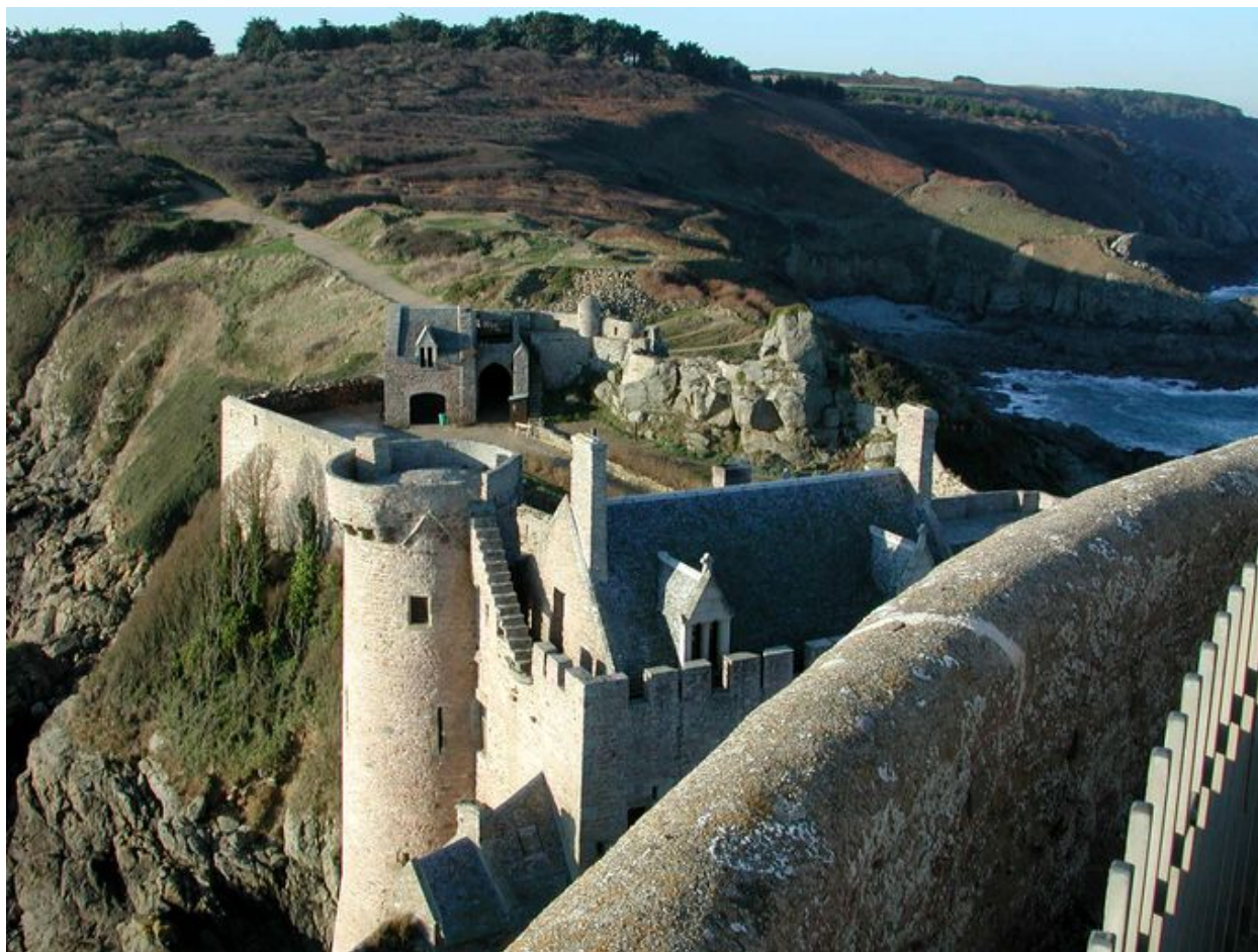
Vue du Fort La Latte
