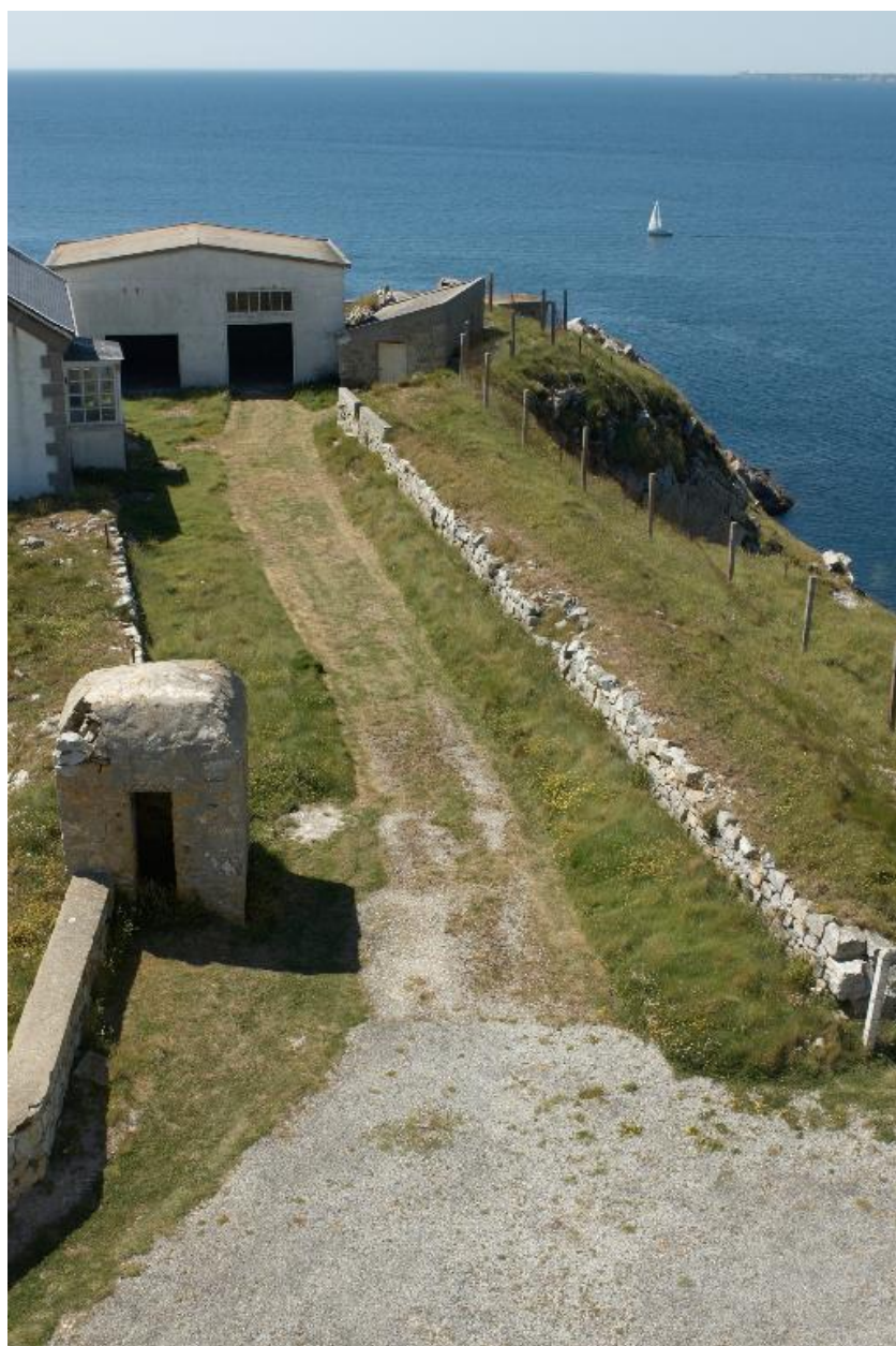
Camaret, pointe du Toulinguet : installation du phare
