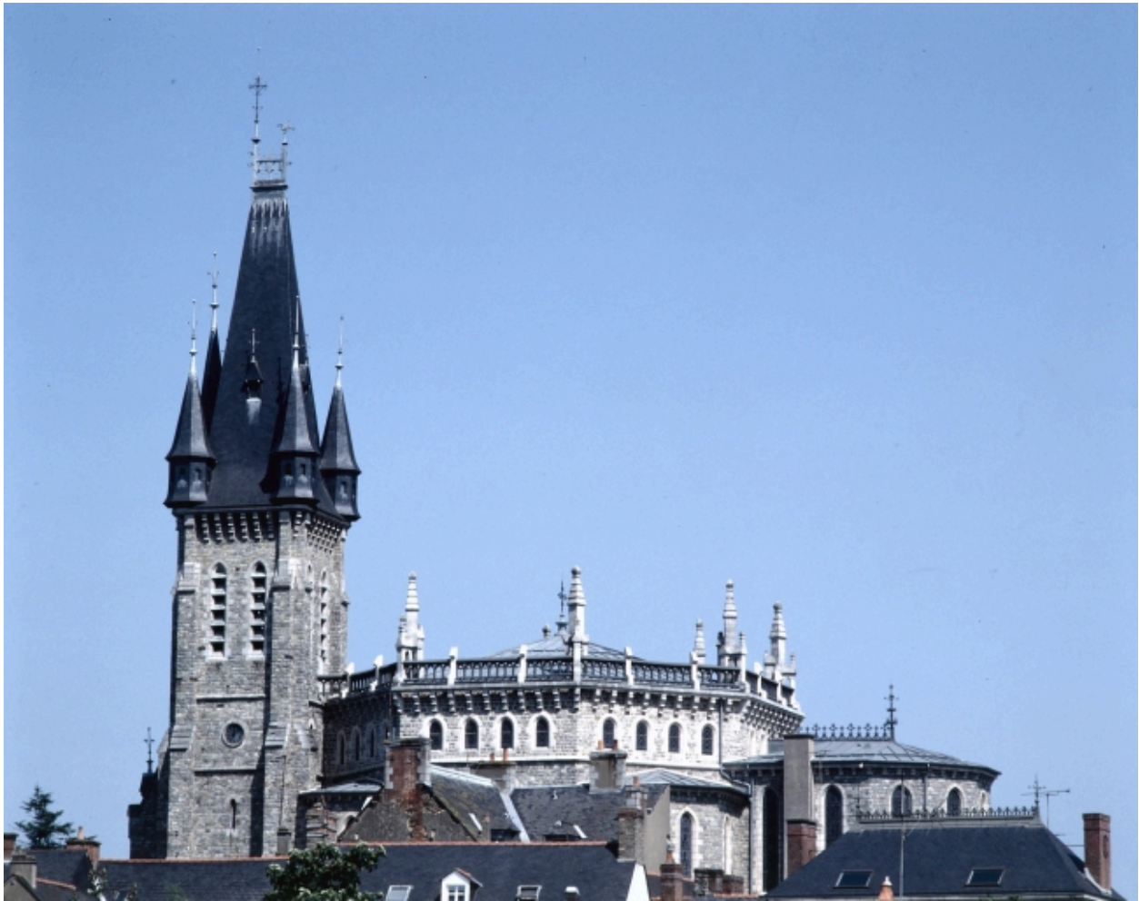
Elévation Nord : vue générale
