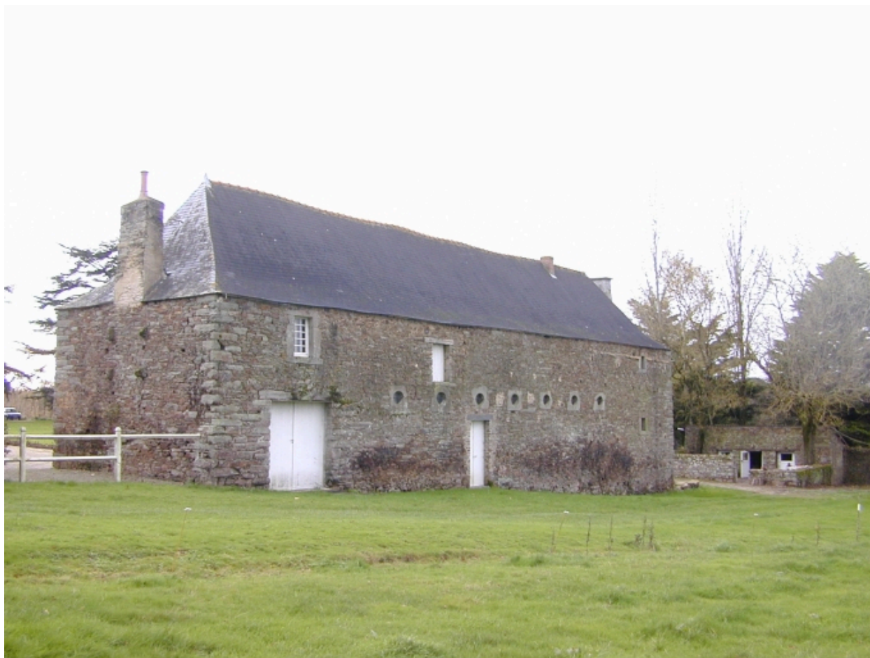
Communs, façade postérieure : vue générale nord-est
