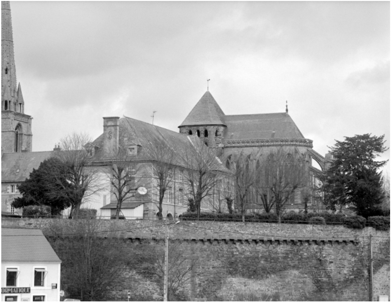
Elévation Sud-Ouest : vue générale
