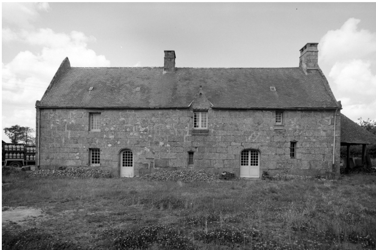
Vue générale de la façade sud
