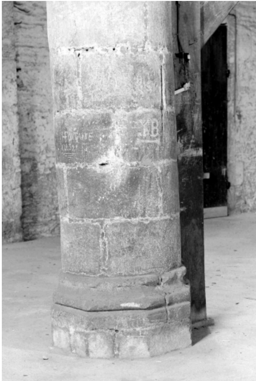
Détail d'une pile de la nef
